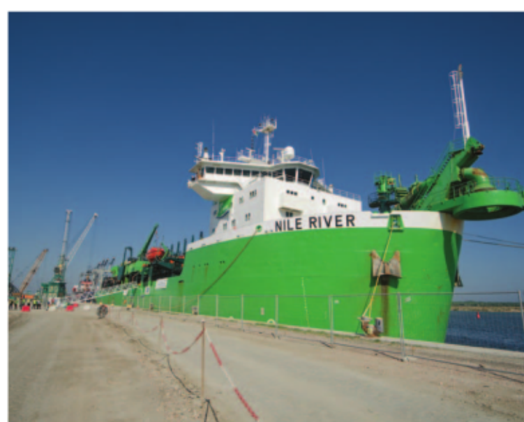
Il cantiere dell'hub portuale di Ravenna FOTO MASSIMO FIORENTINI
